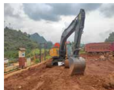
信发施工项目 新能源电动挖掘机应用现场
