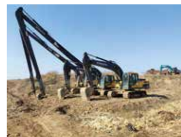
中铁十四局小清河复航工程施工项目
