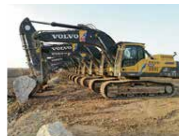
山东省高速路桥集团龙青高速施工项目
